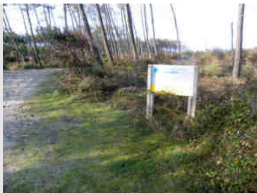
Dans la frange, le chemin parallèle à la dune est très fréquenté, notamment par les véhicules. Aucune barrière n'existe, et la matérialisation timide de la réglementation n'est guère incitative.
