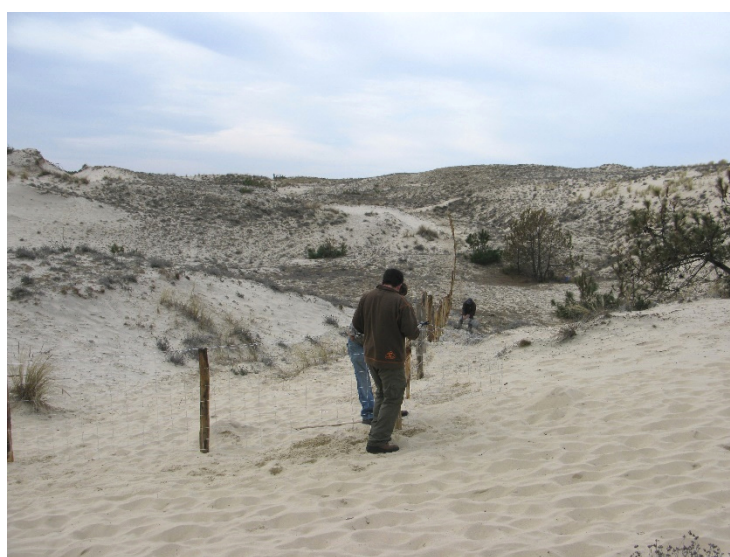
Pose d'un exclo par les ouvriers de l'ONF
