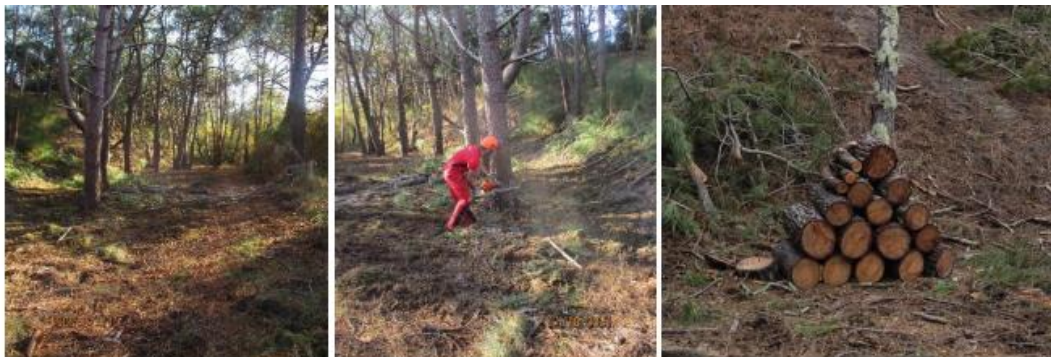
Figure 2: Lette refermée avant travaux (à gauche), lette en cours de travaux (au centre) et branchages et piles de troncs mis en place pour abriter la faune (S. MAITIA et D. BOULET ONF)
