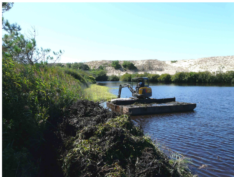
Photo 2 : Arrachage de la Jussie à la mini pelle sur barge, en bordure du grand étang
