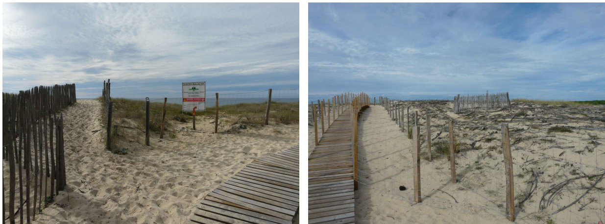
Photo 6 et 7 : Aménagements de mise en sécurité de l'accès au belvédère
