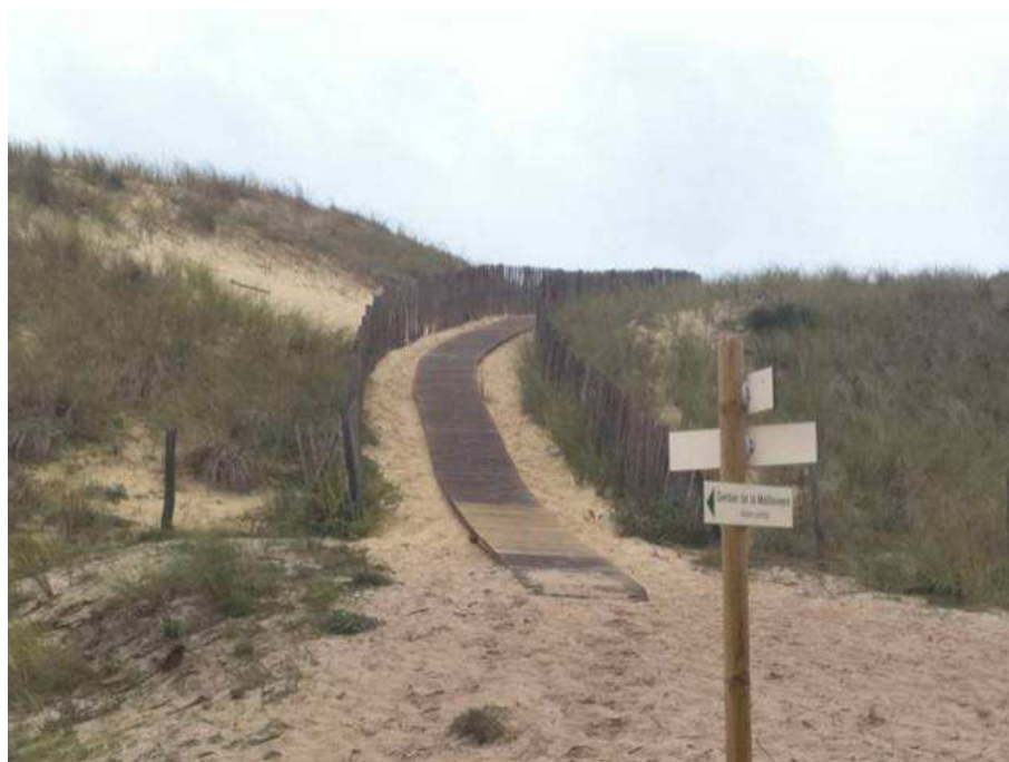
photo 7 : Caillebotis, clôtures et ganivelles le long de l'accès au belvédère
