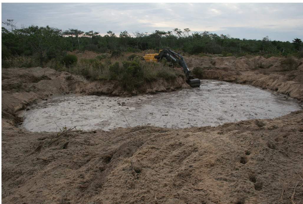
Photo 1 : Travaux de création des mares dunaires
