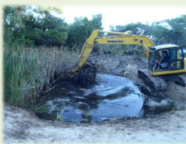
Mare n° 2 : Extraction des massettes, et réalisation d'une zone plus profonde pour limiter leur progression, et favoriser la permanence des eaux. (Photo : Marc Fournier, ONF).
