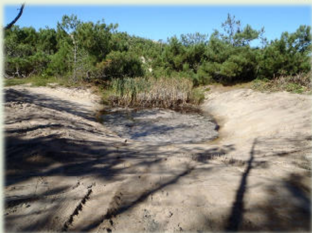
Mare n° 2. Travaux achevés, les berges sont moins abruptes (Photo : Marc Fournier, ONF)
