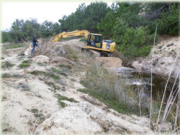
Mare n° 1, début des travaux
