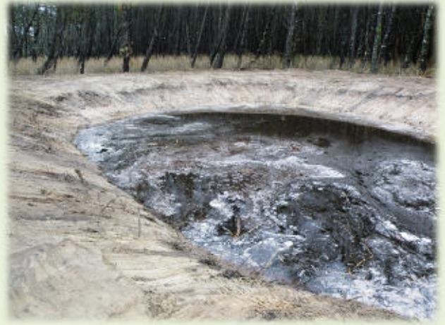
Mare n° 3 : dès la fin des travaux, le niveau d'eau se trouve à environ 0,50 m du sol environnant (le bourrelet constitue une surhauteur). Des troncs ont été placés dans la mare.
