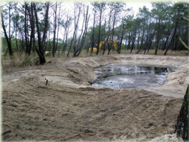
Mare n° 3. après travaux. A titre d'essai, le sable a été placé en bourrelet autour de la mare, afin de réduire les temps de travail mécanique.
