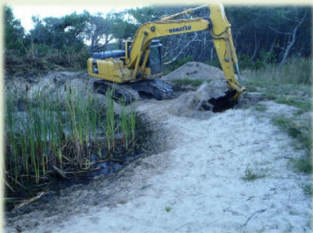
Mare n° 2. Réalisation de berges en pentes plus douces côté est (Photo : Marc Fournier, ONF)
