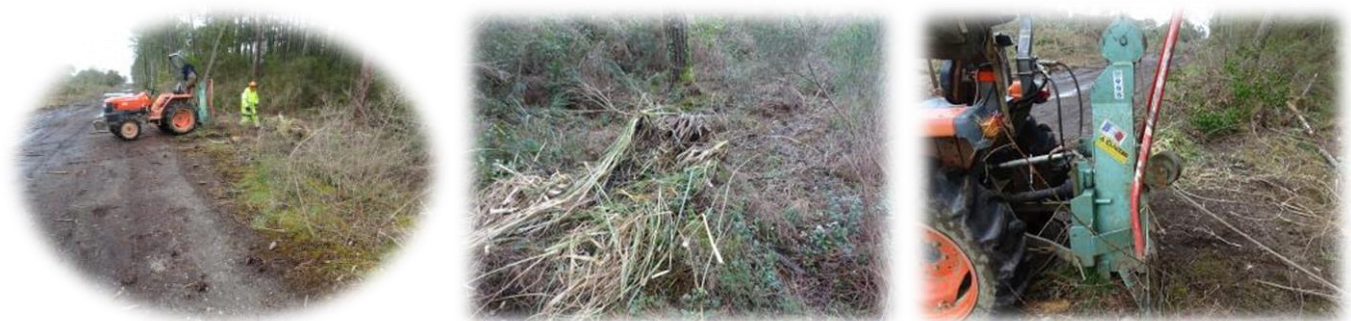
Le tracteur en station sur le pare-feu ; un pied d'herbe de la pampa ramené par le treuil ; le treuil et son renvoi orientable.
