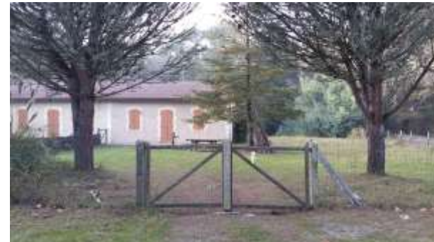
Portail et grillage de la maison forestière
